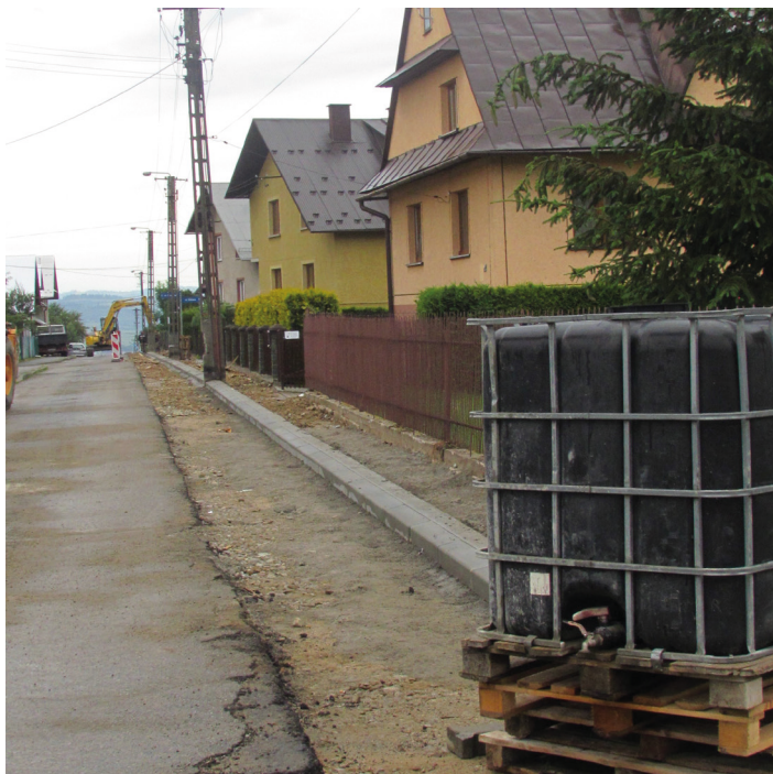
ul. Wyspiańskiego w trakcie modernizacji
